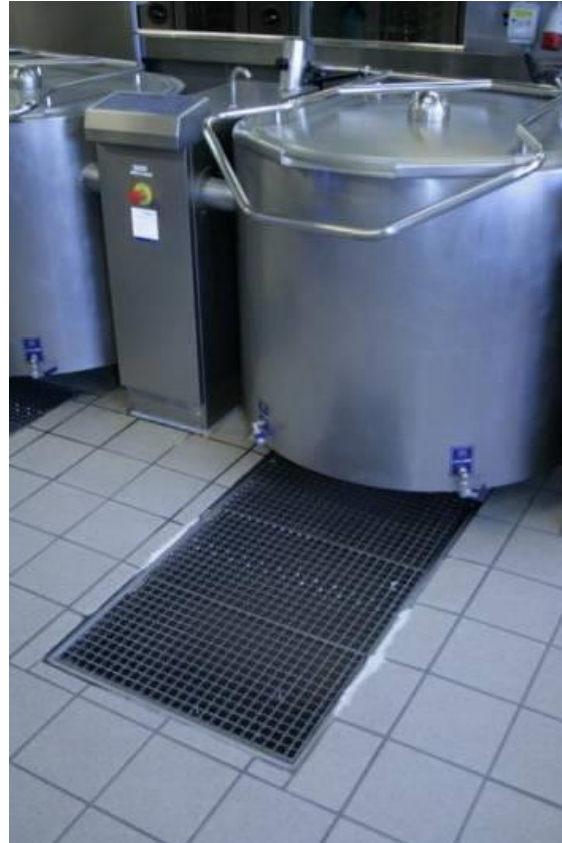
Bodové odvodnenie (EN 1253) vaničky
